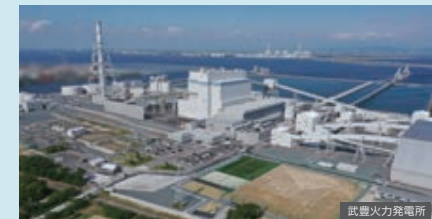
武豊火力発電所
