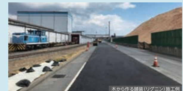
木から作る舗装(リグニン)施工例
