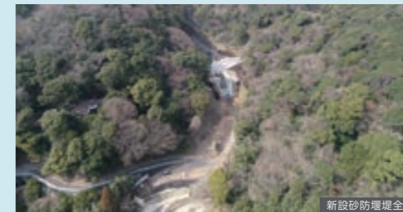
新設砂防堰堤全景
