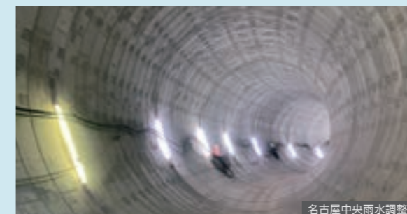
名古屋中央雨水調整池
