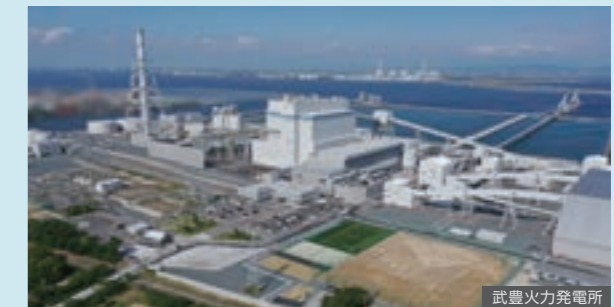
武豊火力発電所
