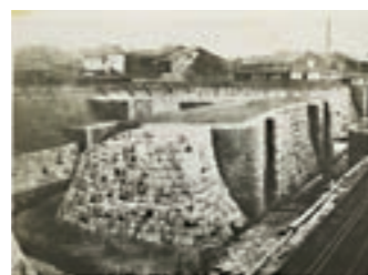
琵琶湖疏水閘門
