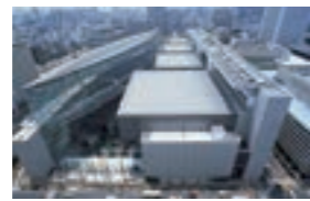
東京国際フォーラム ホール棟
