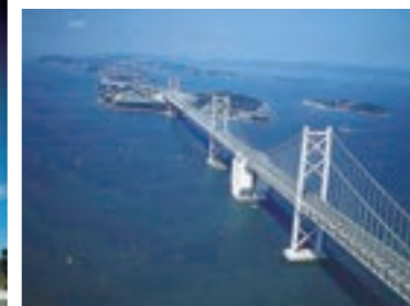
南北備讃瀬戸大橋 (下部工、北工区)
