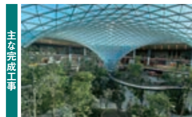
カタール ハマド国際空港旅客ターミナル拡張工事(カタール国) 発注者：カタール空港運営管理会社(MATAR)
