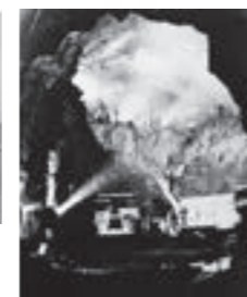
関西電力黒部川第4発電所 (第5工区)
