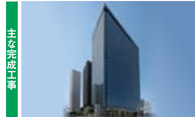
西新宿五丁目北地区防災街区整備事業に係る施設建築物新築工事(東京都新宿区) 発注者：西新宿五丁目北地区防災街区整備事業組合
