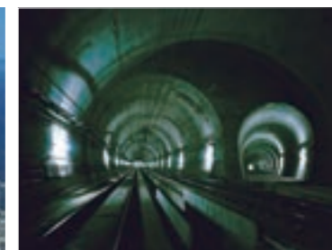
青函トンネル (吉岡工区)
