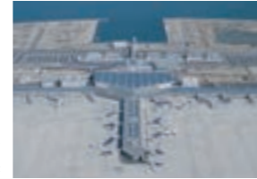
中部国際空港旅客ターミナルビル ©中部国際空港提供
