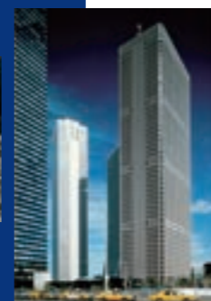
新宿センタービル
