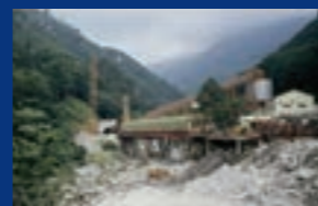
上越新幹線大清水トンネル
