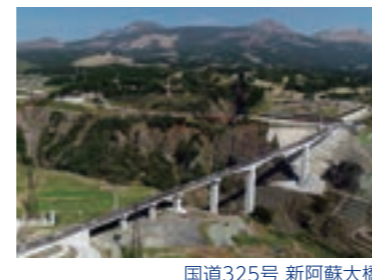
国道325号 新阿蘇大橋
