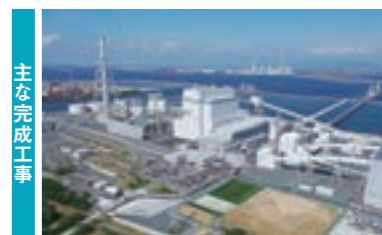
武豊火力発電所5号機 土木建築工事(愛知県知多郡) 発注者：JERA/パワー武豊合同会社
