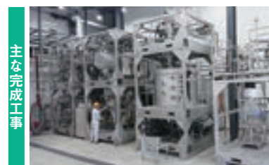
株式会社高砂ケミカル iFactory建設工事(静岡県掛川市) 発注者：(株)高砂ケミカル
