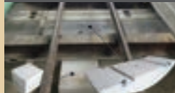
歩床ブロック インパットブロック 千葉県印西エリア洞道新設工事(その2) 発注者: 東京電力パワーグリッド㈱
