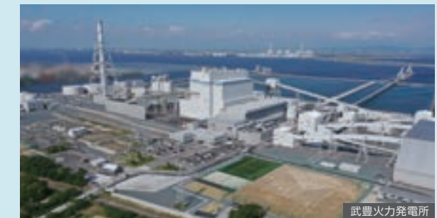
武豊火力発電所
