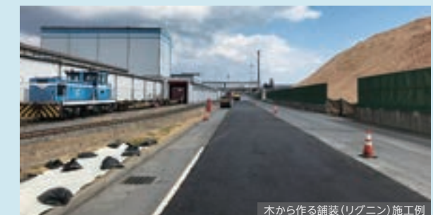
木から作る舗装(リグニン)施工例
