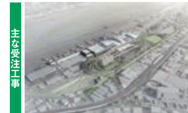
福岡空港国際線ターミナルビル等増改築工事 (福岡県福岡市) 発注者：福岡国際空港(株)
