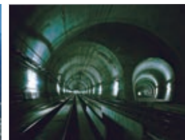
青函トンネル (吉岡工区)
