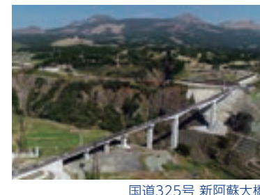
国道325号 新阿蘇大橋
