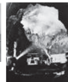
関西電力黒部川第4発電所 (第5工区)
