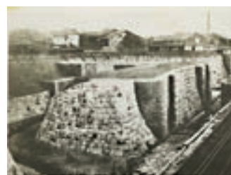
琵琶湖疏水閘門
