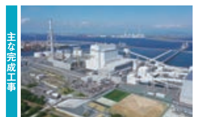
武豊火力発電所5号機 土木建築工事(愛知県知多郡) 発注者：JERA/パワー武豊合同会社
