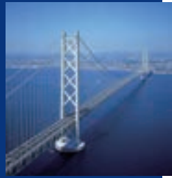
神戸淡路鳴門自動車道 明石海峡大橋3P (下部工その2)
