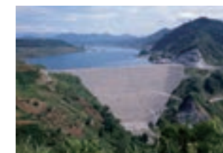
チラタ水力発電所
