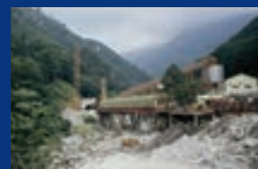
上越新幹線大清水トンネル
