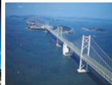
南北備讃瀬戸大橋 (下部工、北工区)
